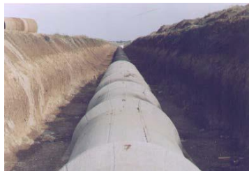
Fig. 5.7. Tuburi de beton cu îmbinarea caracteristică
